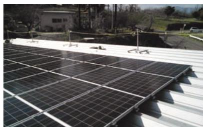
折板屋根へのソーラー発電設備設置工事の安全・安心な作業空間を確保します。
