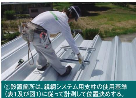
②設置箇所は、親綱システム用支柱の使用基準(表1及び図1)に従って計測して位置決めする。
