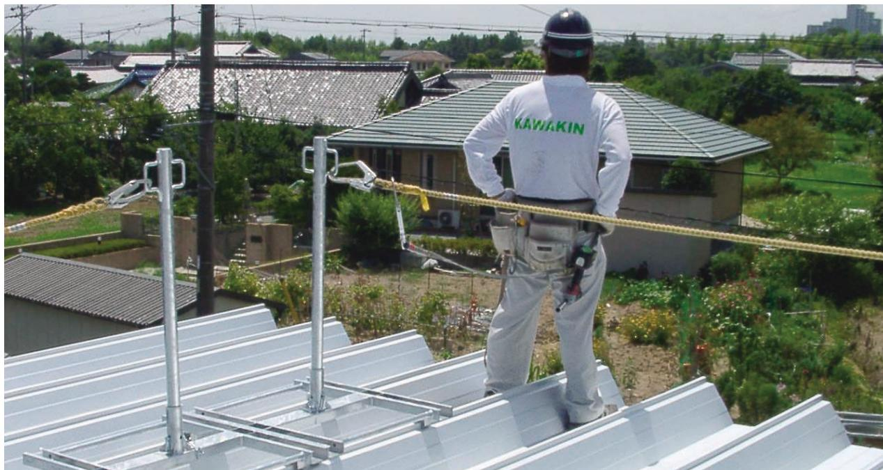
ショッピングセンター、倉庫など大空間建築物に多く採用されるハゼ締めタイプの金属製長尺折板屋根。その屋根の軒先、ケラバ、開口部からの墜落・転落を防ぎます。
